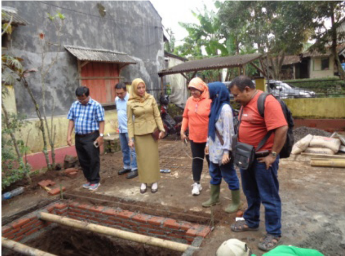
Pemantauan pembangunan sumur resapan oleh USAID IUWASH dan CCFI di Desa Ketindan, Kecamatan Lawang, Kabupaten Malang.
